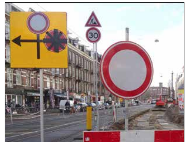
Aanleg Rode Loper 31 januari 2105 13.32 uur Ceintuurbaan
