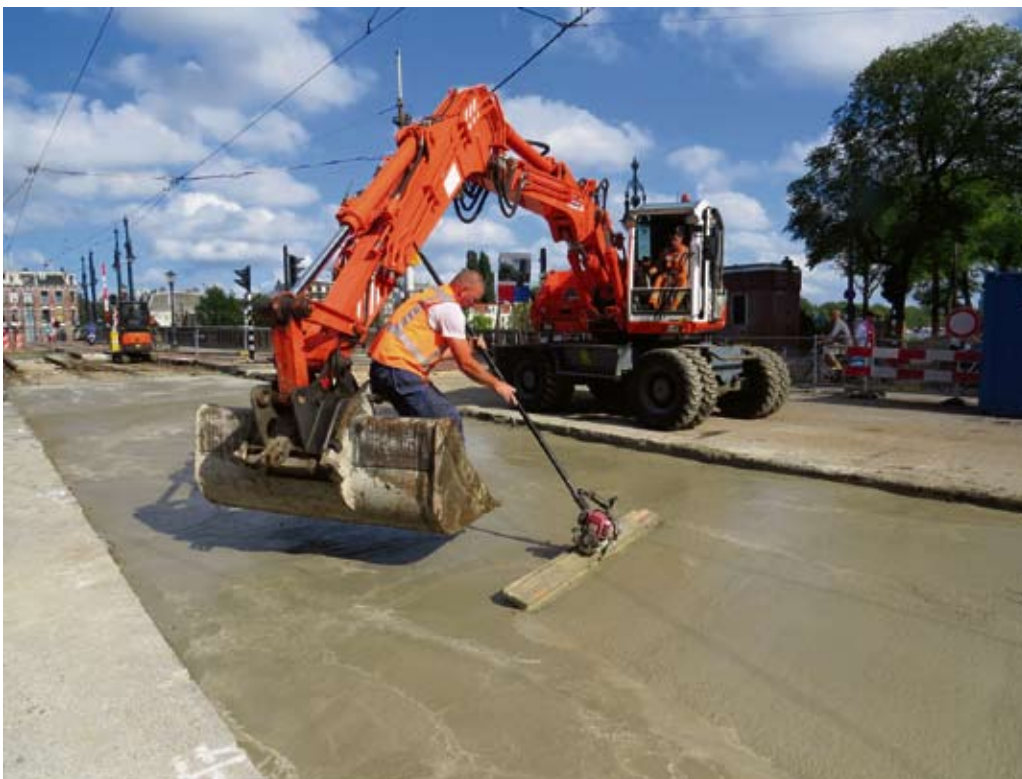
Drukke werkzaamheden op de Ceintuurbaan hoek Amsteldijk waar de tramrails worden vervangen en het wegdek vernieuwd. Foto's: Christine Westerveld
