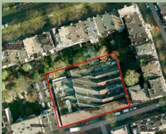
Luchtfoto van de huidige situatie rond het pand aan de Van Ostadestraat 233. Het pand is met rood kader aangegeven. Foto afkomstig uit het bestemmingsplan van het stadsdeel.
