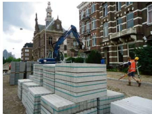
Nieuwe bestrating van de Amsteldijk tussen de Tolstraat en de Ceintuurbaan nog in volle gang. Foto: Christine Westerveld
