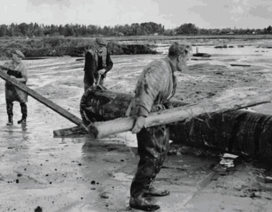
1955 Het begin van de bouw van Buitenveldert
