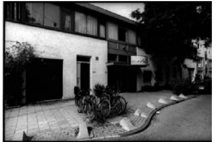
Een gelegaliseerd pand in de van Ostadestraat, een goed voorbeeld van de positieve bijdrage die de kraakbeweging aan de stad heeft geleverd. Dit in 1980 gekraakte pand biedt tegenwoordig onderdak aan een drukkerij, een actieblad en het Ostade Theater. Daarnaast woont er een klein aantal mensen boven de bedrijfspanden.
